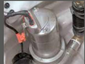
Pumpe mit Schwimmerschalter
